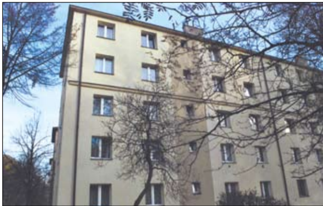
Budynek WM przy ulicy Falata po remoncie
