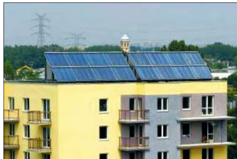
Solary na budynku KSM w Katowicach.
