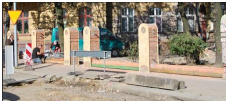
Odbudowa zabytkowego ogrodzenia przy ul. Powstańców Warszawskich.
